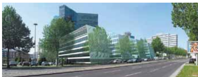
Der Business Park Vienna, mit dem anschließenden Vienna Twin Tower das „Flaggschiff“ der Immofinanz in Österreich, wächst weiter. Noch im Herbst wird eine weitere Ausbaustufe in Angriff genommen
